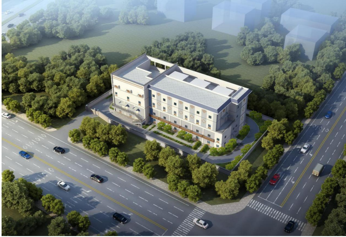
110kV 开泰（江口）变电站
