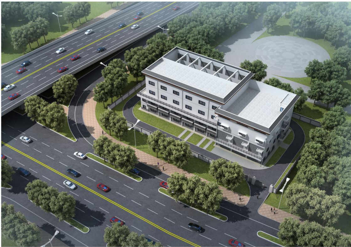
110kV 润亭（亭江）变电站
