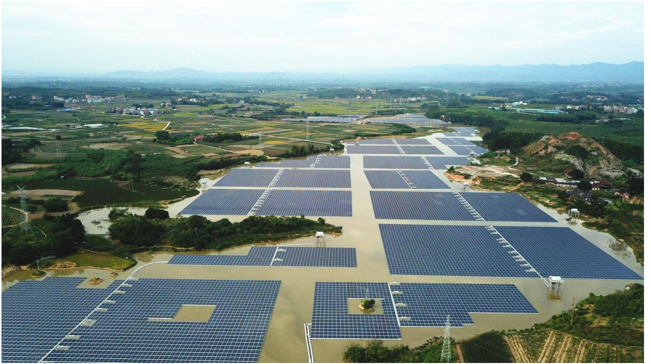
广西右江鱼梁库区里拉沟水面光伏项目(广西第一个大型漂浮式光伏)
