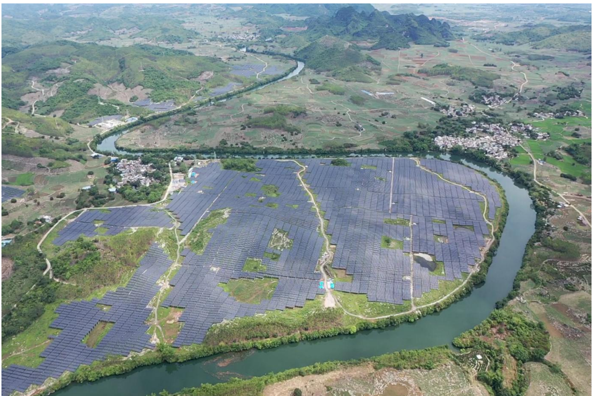
崇左市响水光伏发电项目(广西第一个大规模平价上网光伏项目)
